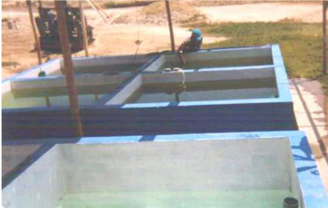
Figura 4. Hatchery de Tilapia Perú S.R.L.
